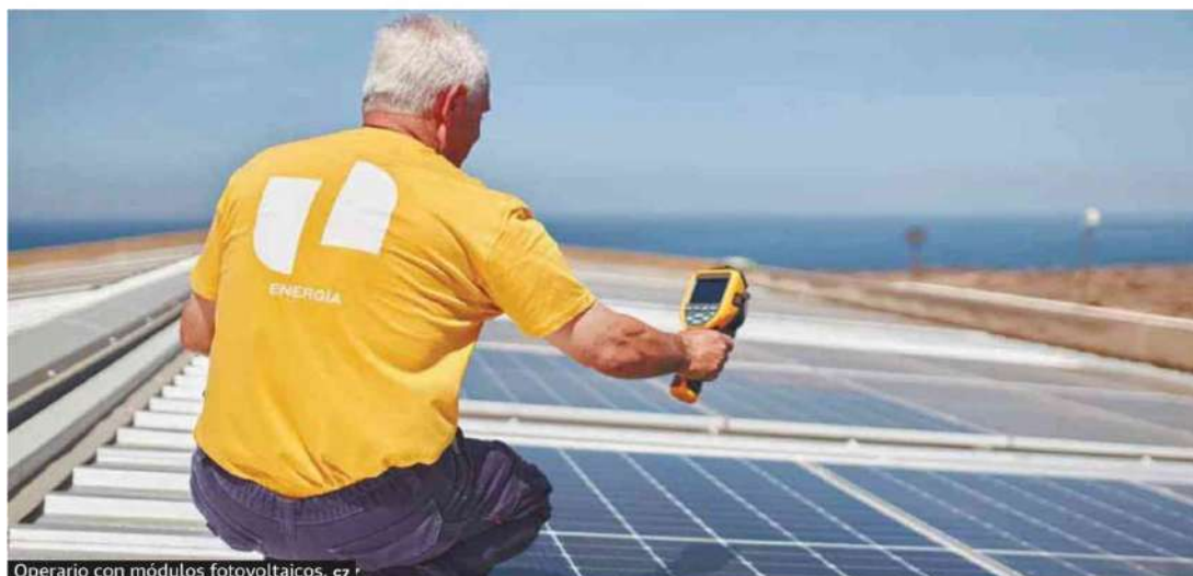
Operario con módulos fotovoltaicos. ©
