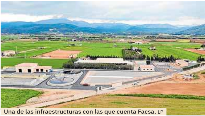
Una de las infraestructuras con las que cuenta Facsa. LP
