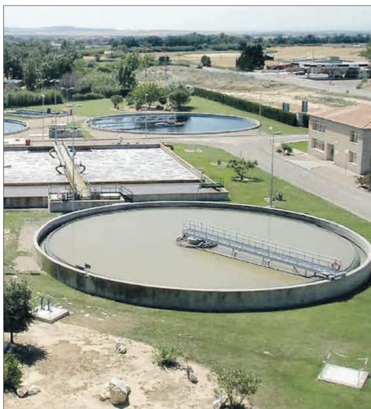
Foto de recurso de una depuradora. EE
